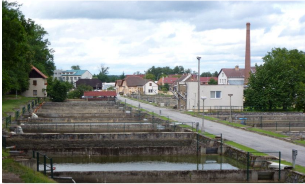
Abbildung 3.4: Hälteranlage in einem großen Fischzuchtbetrieb.
