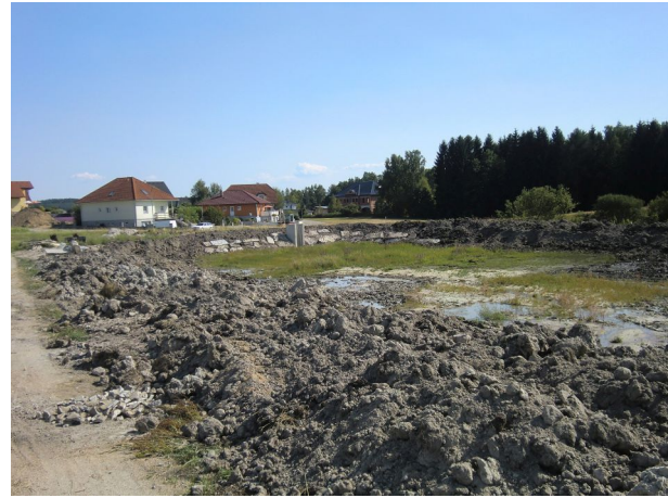
Abbildung 8.3: Neuerrichtung eines Teiches bei Heidenreichstein.
