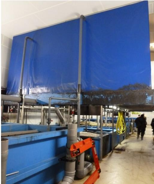
Abbildung 13: Stationärer Tropfkörper, darunter der Pumpensumpf und im Vordergrund ein Sedimentationsbecken.
