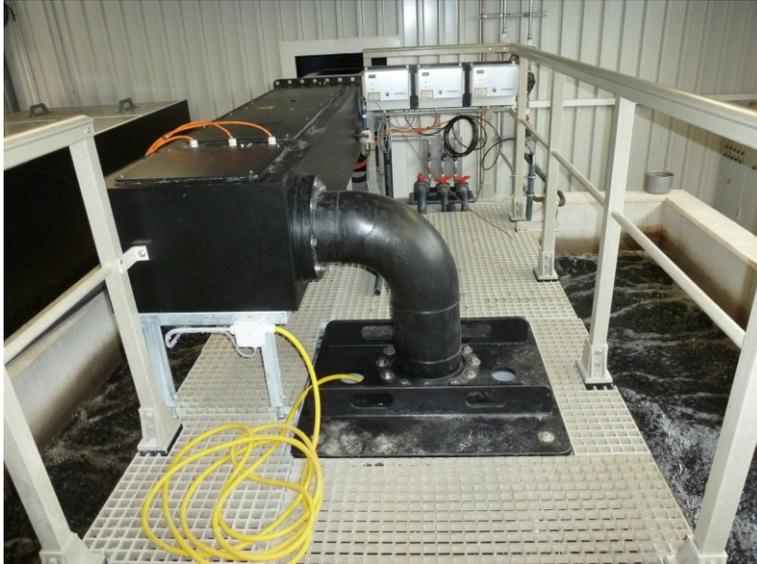
Abbildung 15: Fließbettfilter. Gut erkennbar das untergetauchte in ständiger Bewegung befindliche Filtermaterial.
