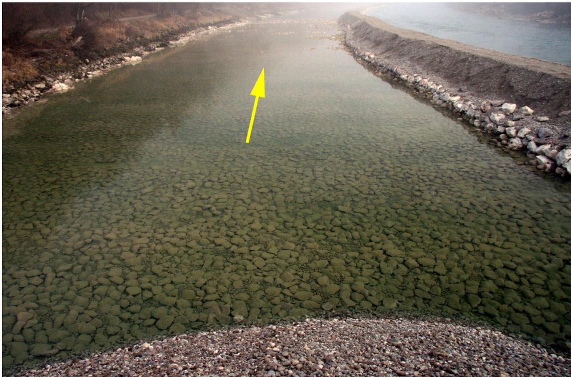
Abbildung 2: Offenes Deckwerk in der Laufener Enge (Bauzustand vor Flutung), Foto: Land Salzburg.
