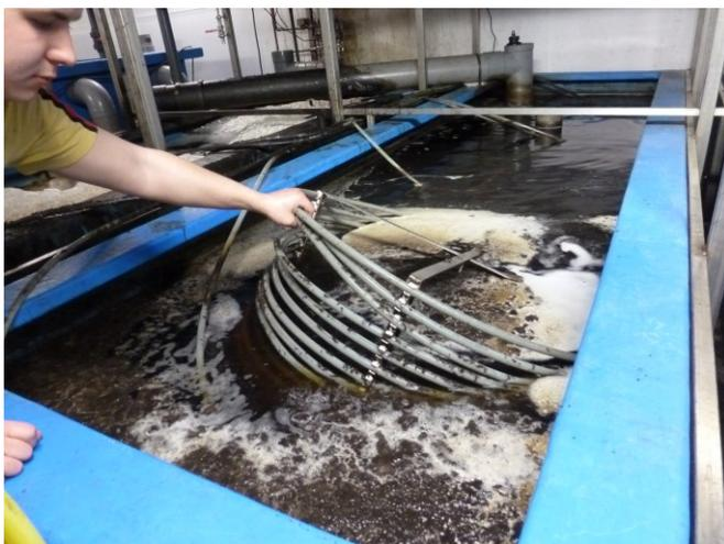
Abbildung 16: Wärmetauscher zum Heizen im Pumpensumpf.
