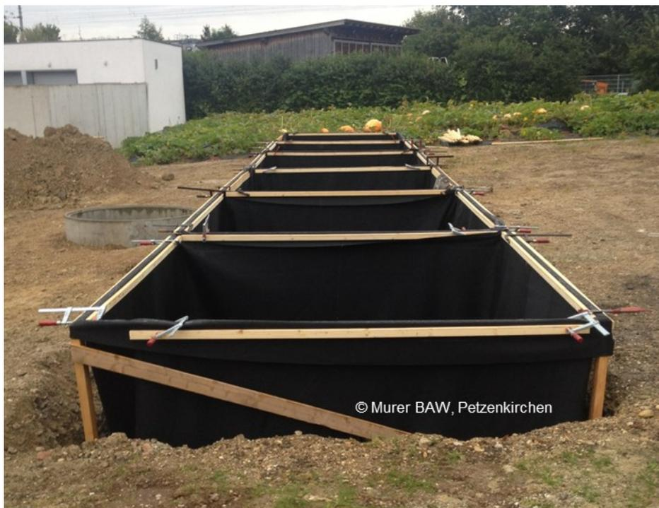
Abbildung 5: Lysimetergefäße der Lysimeteranlage Jägerhausgasse im Bauzustand.
